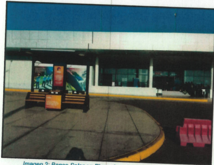
Imagen 2: Banca Solar en Playa de estacionamiento (Vista 2)
