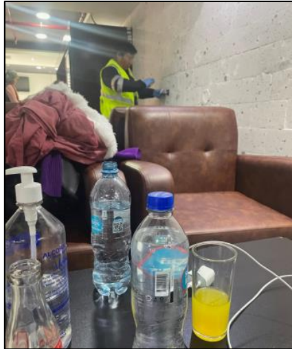
Imagen 02. verifico el equipo de toma de corriente.
