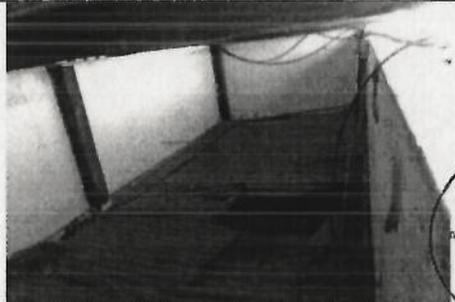
Foto 4: Vista interior del otro lado del ambiente que contiene las placas de fibrocemento; obsérvese las placas de fibrocemento deterioradas y fracturadas.
